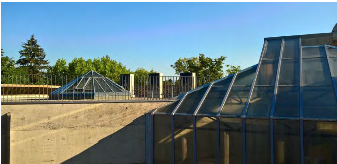
Abbildung 14: Dachaufsicht mit den drei Wärmepumpen. Quelle: SIG-éco21
