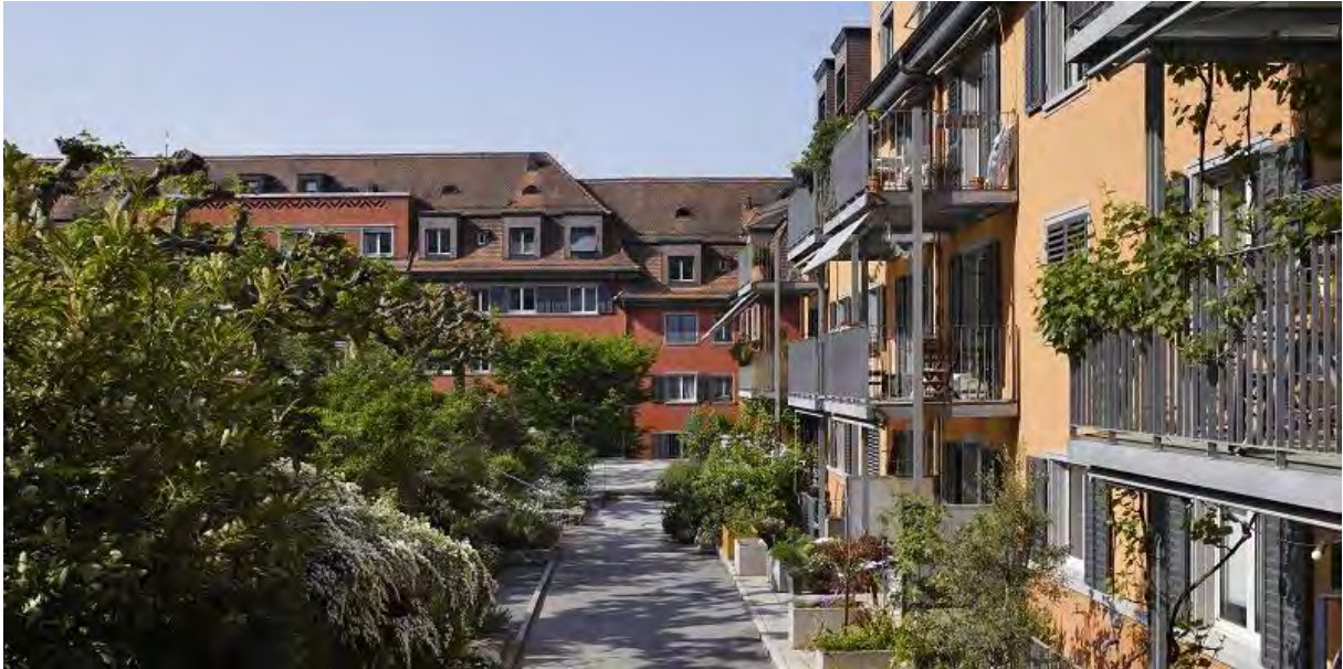
Abbildung 2: Foto der sanierten Siedlung. Quelle: Baugenossenschaft Oberstrass.
