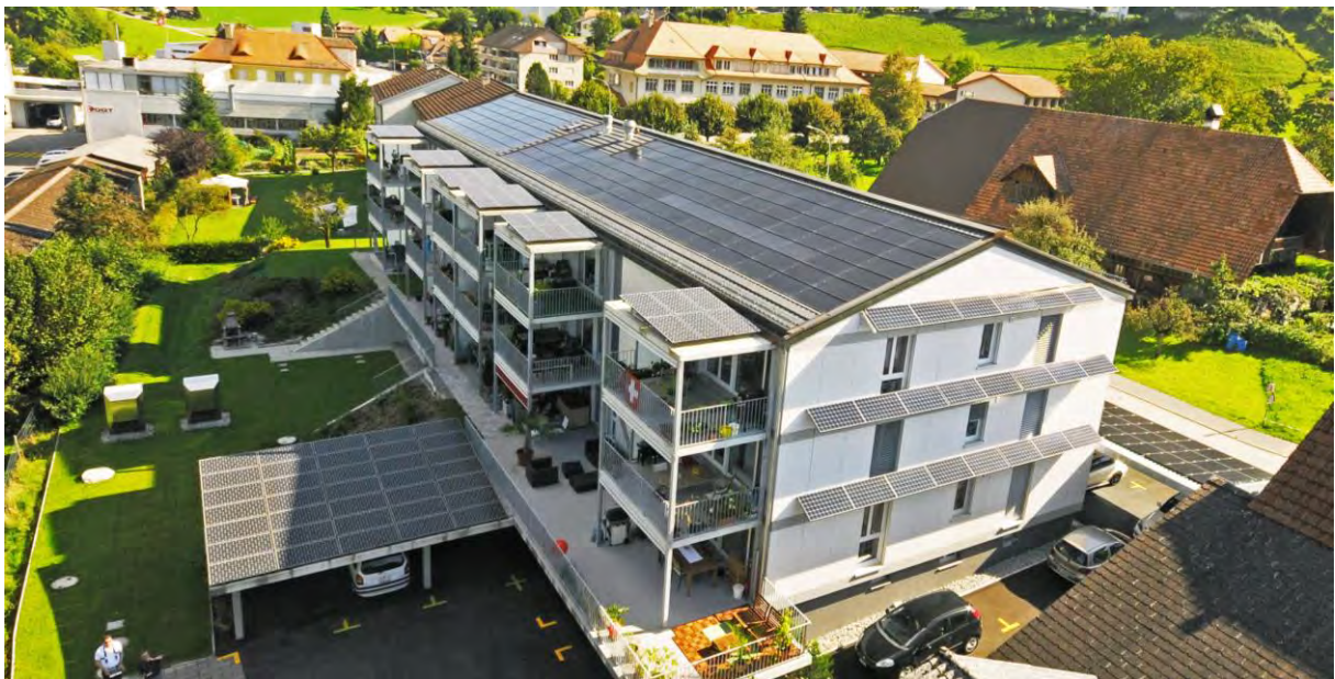
Abbildung 8: Ansicht des Gebäudes nach der Sanierung. Links im Garten stehen die beiden Wärmepumpen.
