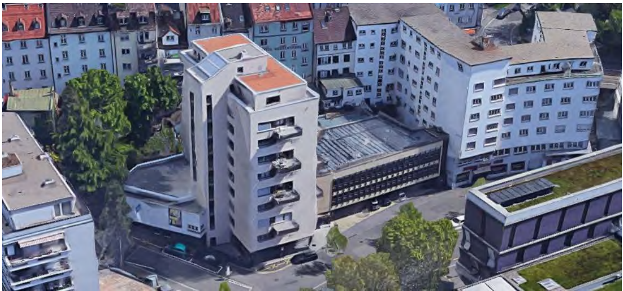
Abbildung 18: Hochhaus mit Split-Ausseneinheit auf dem Dach. Quelle: Google Maps.
