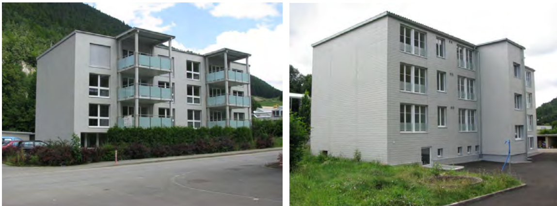
Abbildung 24: Vorder- und Rückansicht des sanierten Gebäudes. Quelle: Minergie
