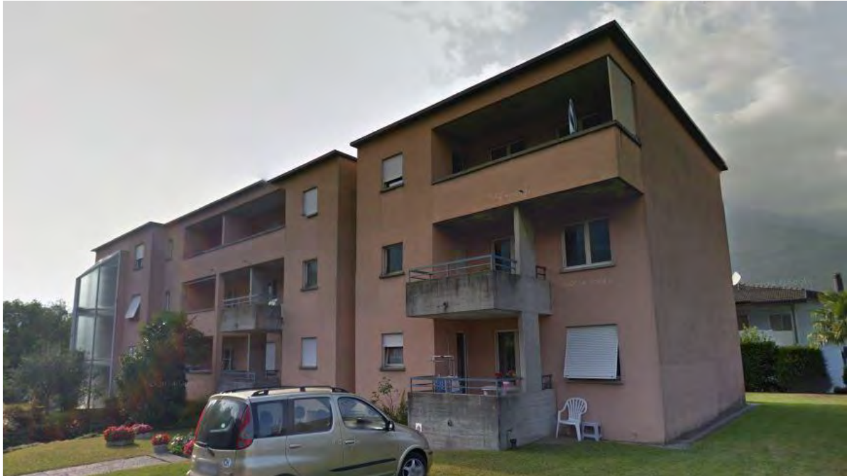
Abbildung 7: Aussenansicht des Gebäudes. Quelle: Google Street View.
