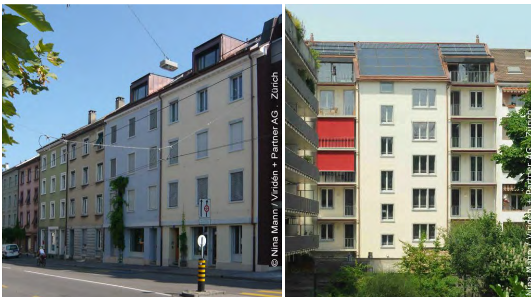
Abbildung 30: Vordere und hintere Fassade der beiden sanierten Mehrfamilienhäuser.
