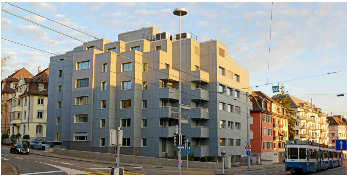
Abbildung 1: Gebäude nach der Sanierung mit Photovoltaik-Fassade und Wärmepumpen auf dem Dach.
