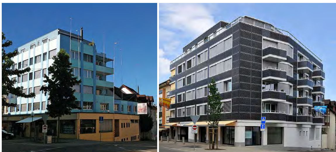
Abbildung 19: Das Gebäude vor und nach der Sanierung. Quelle: @Viridén+Partner AG, Zürich
