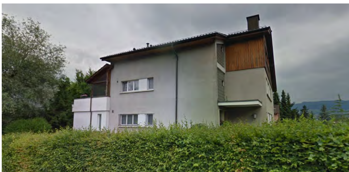
Abbildung 25: Ansicht des Gebäudes vor der Sanierung. Quelle: Google Street View.
