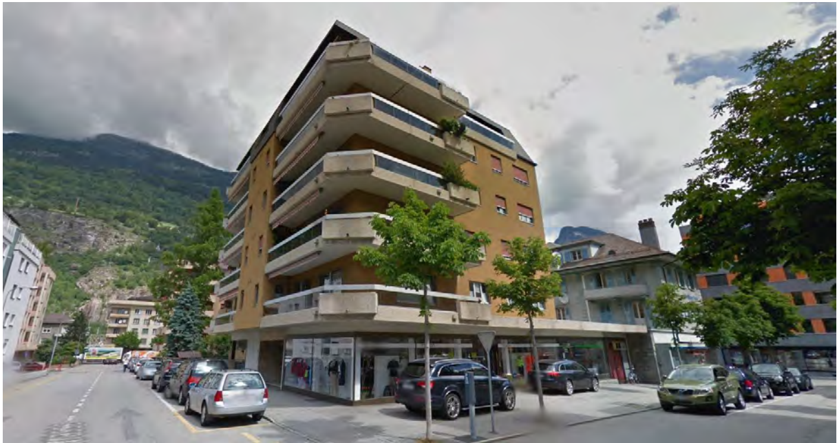
Abbildung 3: Ansicht des Gebäudes. Quelle: Google Street View.
