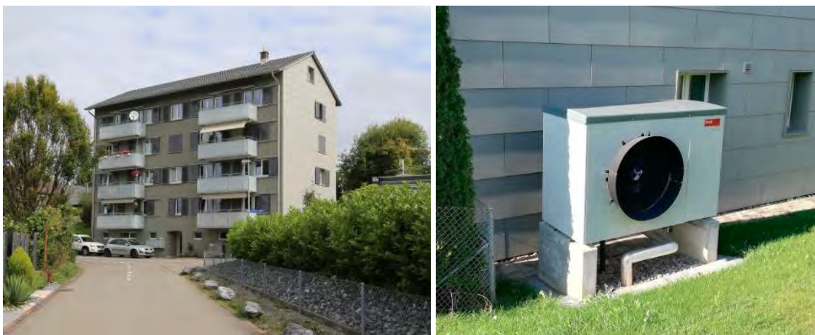
Abbildung 21: Ansicht der sanierten Liegenschaft; aussenaufgestellte Wärmepumpe nahe der Fassade auf Betonsockel. Quelle: voro Immobilien.
