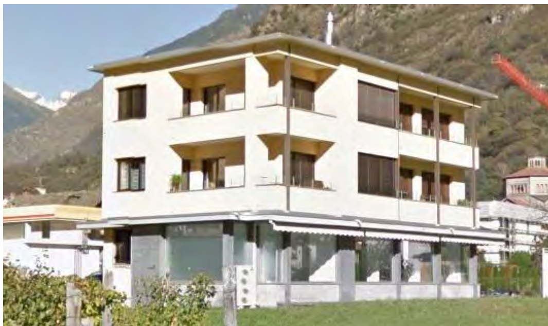
Abbildung 20: Ansicht des Gebäudes. Quelle: Google Street View.
