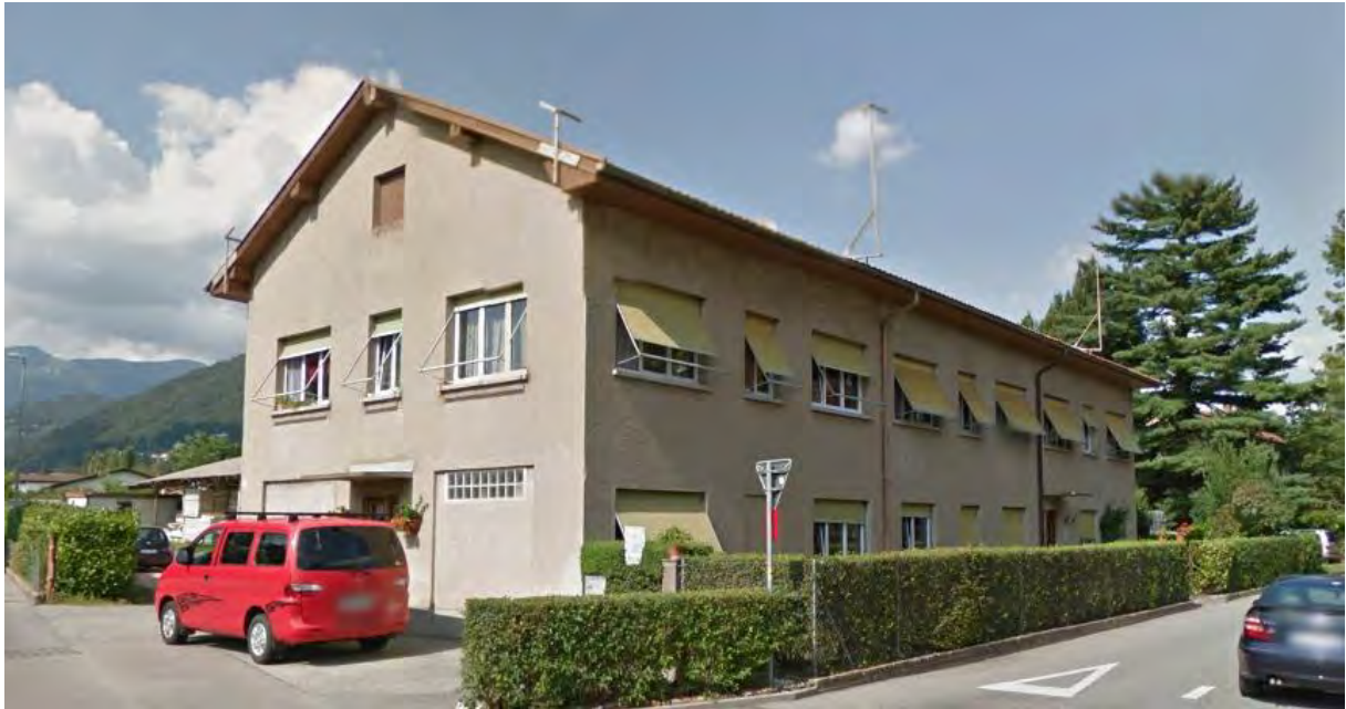
Abbildung 27: Ansicht des Gebäudes vor der Sanierung. Quelle: Google Maps
