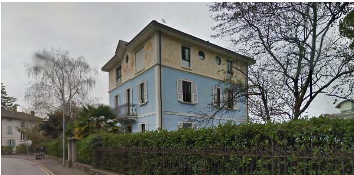
Abbildung 28: Ansicht des Gebäudes vor der Sanierung. Quelle: Google Street View.
