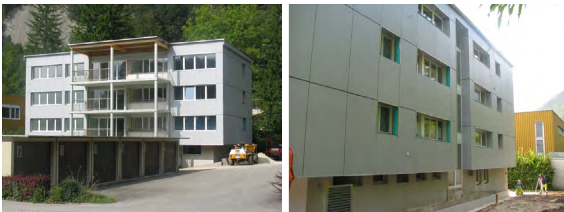
Abbildung 23: Vorder- und Rückansicht des sanierten Gebäudes. Unten links auf dem rechten Bild ist das Fassadengitter der Wärmepumpe zu erkennen. Quelle: Minergie
