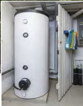
Wärmepumpe im Vorgarten (Ansaugung resp. Ventilator strassenseitig), Pufferspeicher im Keller und Boiler im Nebenraum.
