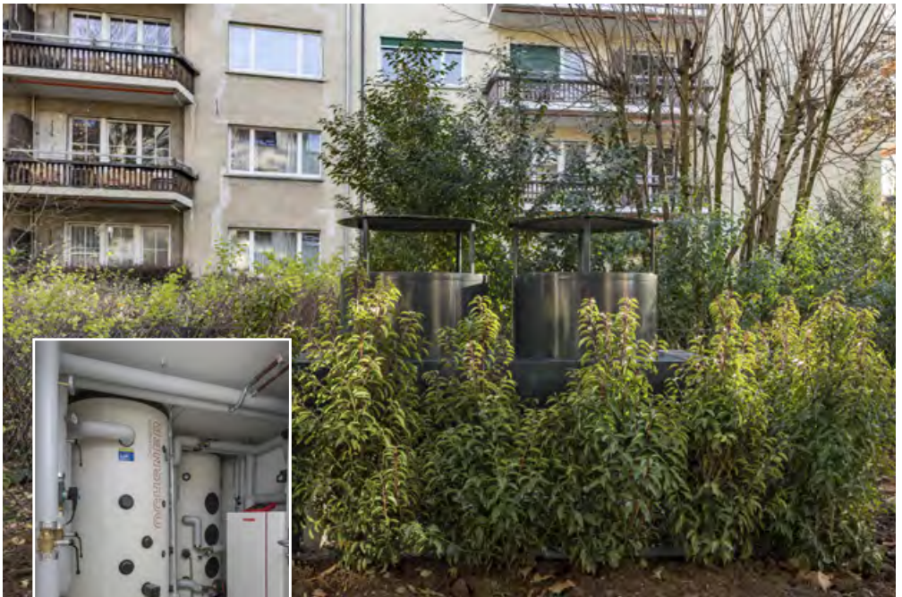
Von Grün umrahmter Tischverdampfer im Garten, Heizungskeller mit Heiz- und Warmwasserspeicher und Innenteil der Wärmepumpe.
