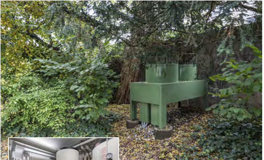
Tischverdampfer zwischen den unter Schutz stehenden Bäumen im Garten, Heizzentrale im Keller.
